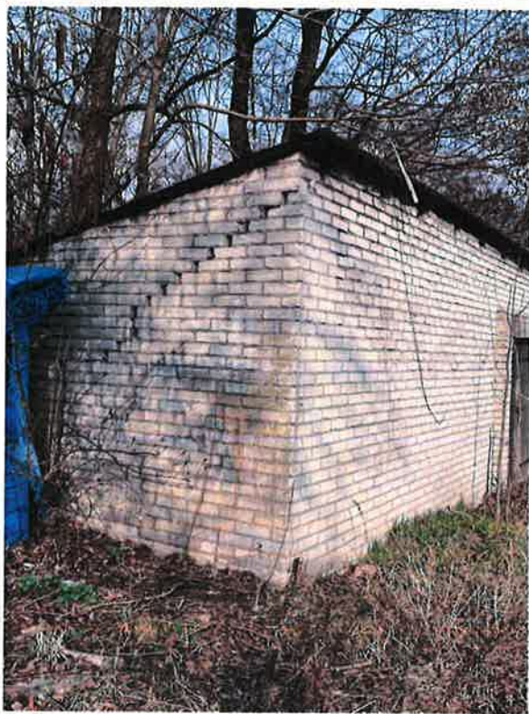
Fot. 3 Pęknięcie ukośne, braki w zaprawie cementowej
