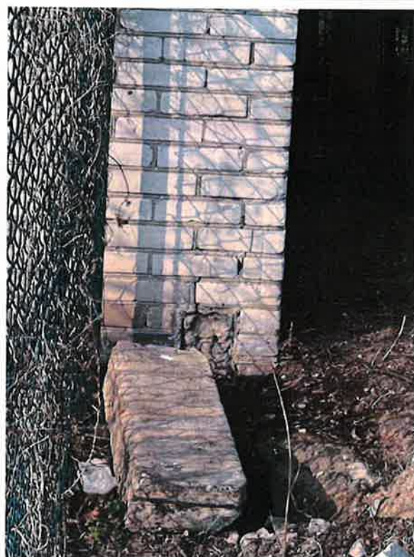
Fot. 4 Pęknięcie oraz ubytki muru
