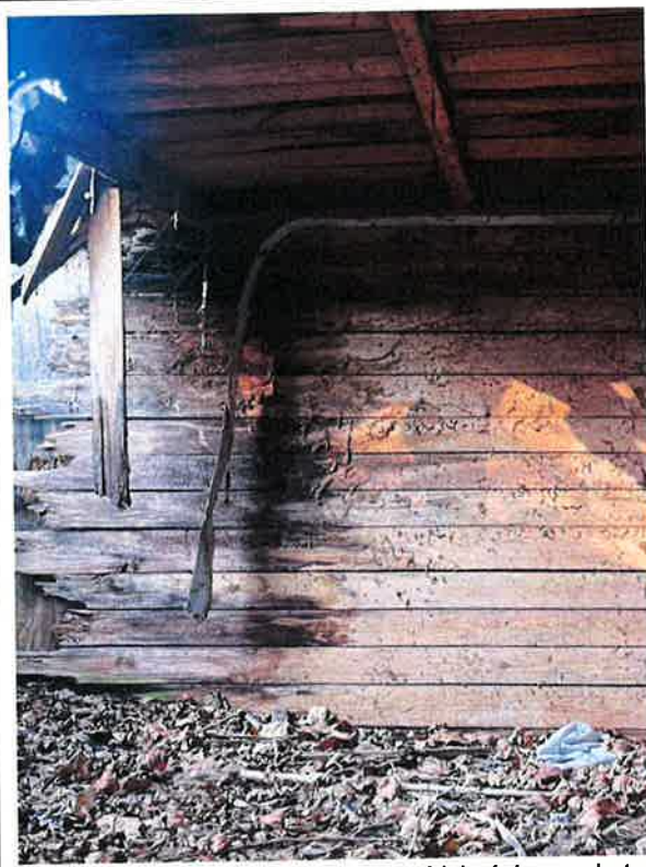
Fot. 10 Zniszczenie drewnianego obicia ścian w skutek butwienia drewna
