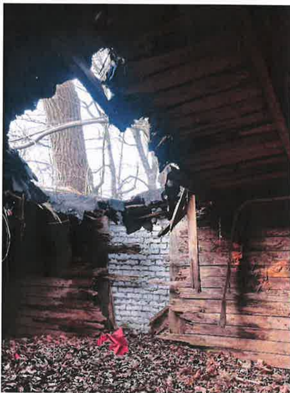
Fot. 5 Zniszczenie konstrukcji i pokrycia dachu oraz wewnętrznego obicia ścian z drewna
