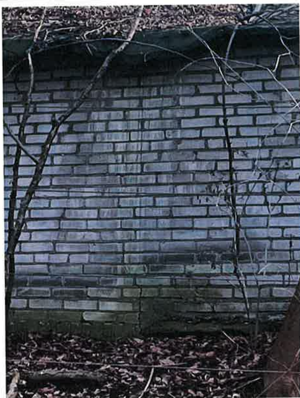
Fot. 9 Spękania pionowe muru, zacieki oraz wykwyty
