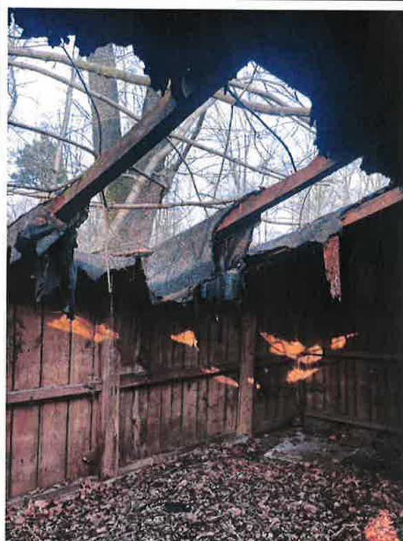
Fot. 6 Zniszczenie konstrukcji i pokrycia dachu
